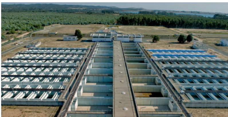
Figura 3 - Fotografia aérea das infraestruturas das instalações da ETA de Morgavel (Filtros e Decantadores)
