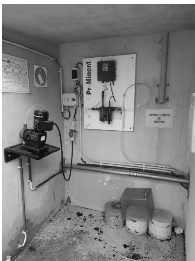
Figura 7: Abrigo onde será feita a instalação do painel de análise e doseamento na FA de Chelas
