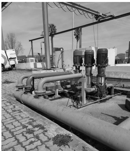
Figura 9: Grupo hidropressor existente na FA de Frielas
