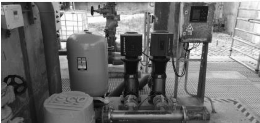
Figura 2: Grupo hidropressor existente na FA de Alverca
