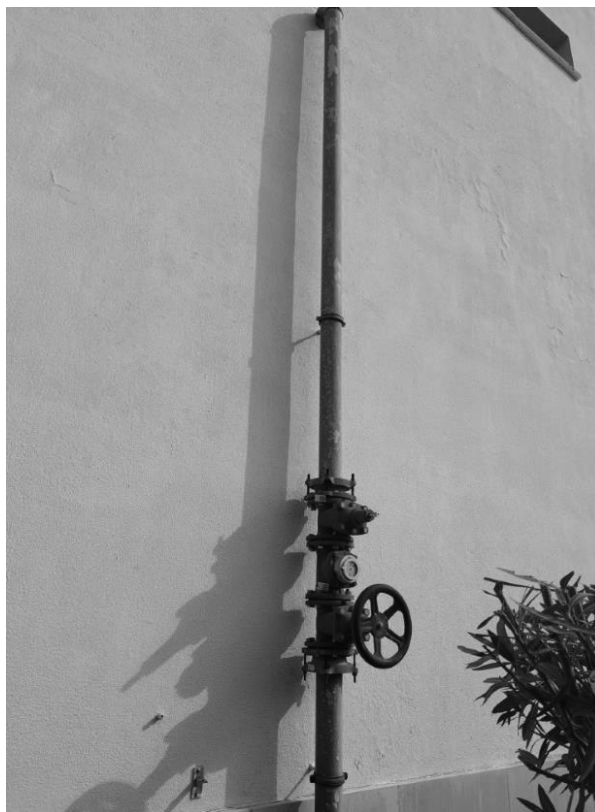
Figura 14: Tubagem de alimentação à cisterna de água tratada
