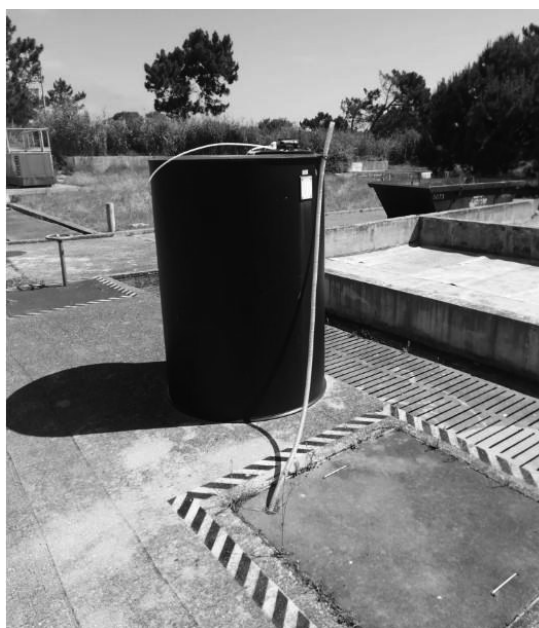
Figura 5: Depósito de hipoclorito existente na FA do Casalinho
