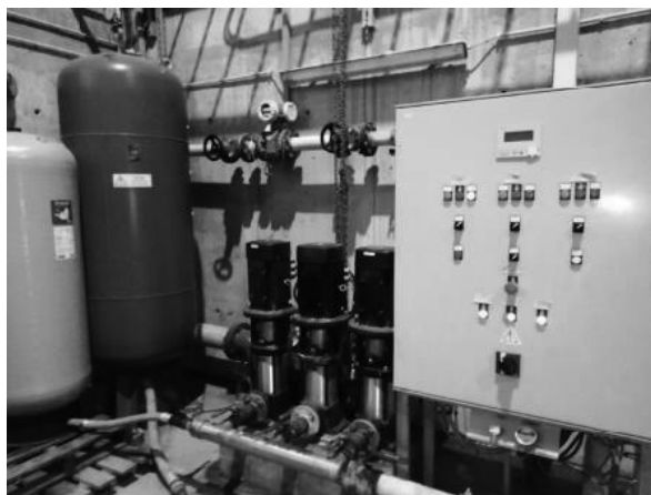
Figura 12: Grupo hidropressor existente na ETAR da Guia
