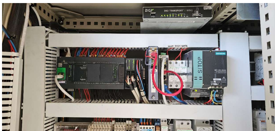
Figura 7- Exemplo de uma gateway comunicações Tbox TG2 500, instalada na EEAR Bias 1
