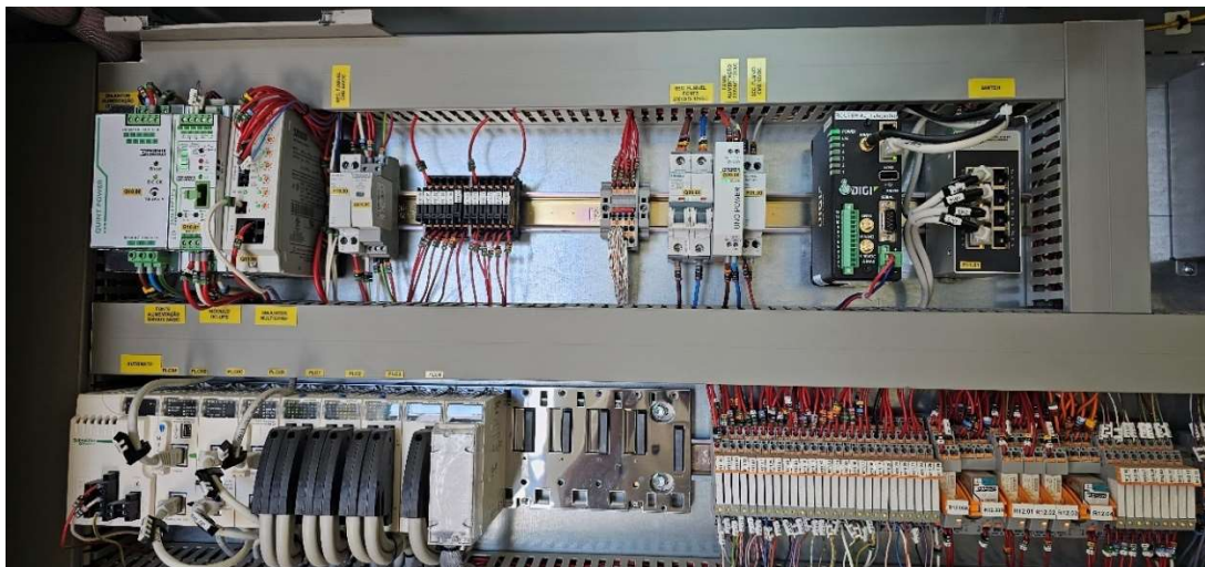
Figura 4- Exemplo do router 4G "IX30" e carta de comunicação BMXNOR0200H, instalados na EEAR de Olhão-Faro
