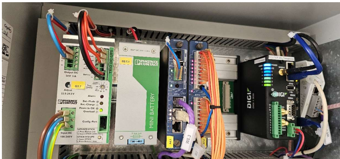
Figura 6- Exemplo de uma gateway comunicações Tbox MS-CPU32, instalada na EEAR Dunas Douradas
