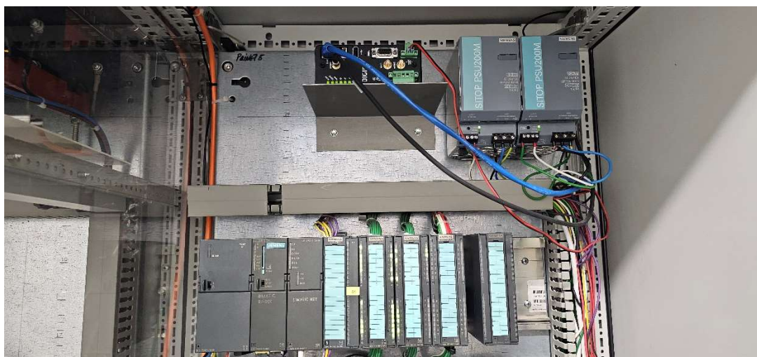
Figura 8- Exemplo de PLC c/ SIPLUS RIC 6AG6003-1CF00-OCA0, instalada na EEAR 3 Galé
