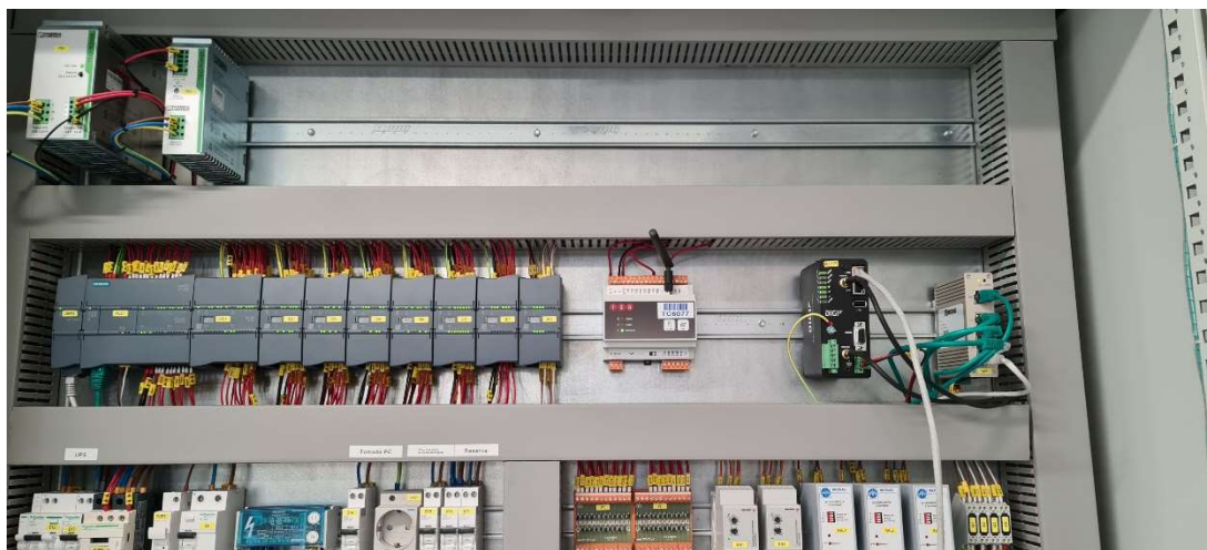
Figura 5- Exemplo do router 4G "WR31" e carta de comunicação CP 1243-1, instalados na EEAR Ferragial
