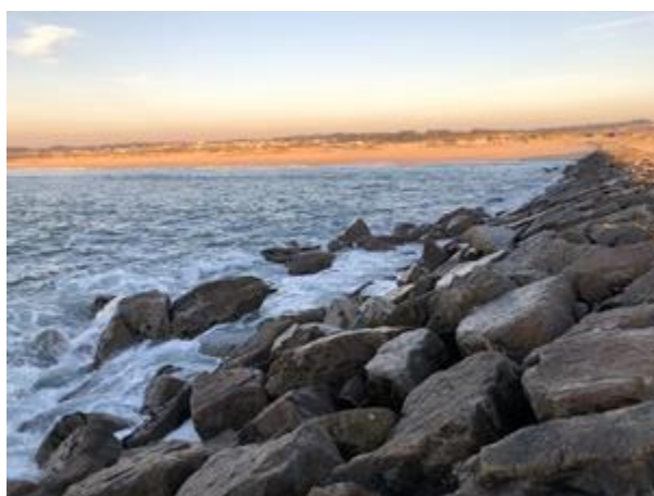
Figura 22 – Fotografia do deslocamento parcial do manto de proteção no esporão norte de Paramos.
