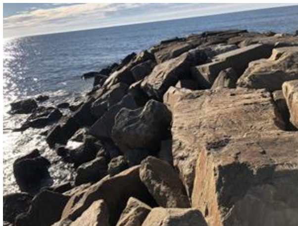
Figura 14 – Fotografia do colapso parcial do talude de sotamar do esporão sul da proteção da foz da ribeira de Silvalde.
