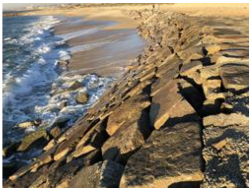
Figura 28 – Fotografia dos blocos deslocados na face noroeste da proteção aderente.
