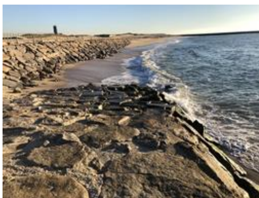
Figura 27 – Fotografia da zona colapsada da rampa sul da proteção aderente.
