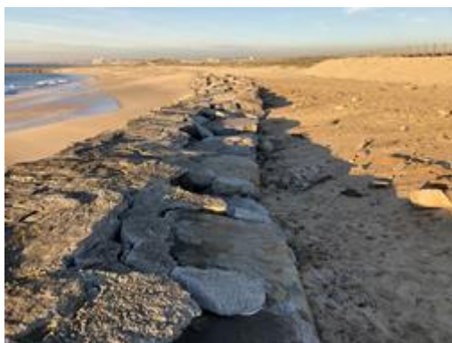
Figura 29 – Fotografia do assentamento dos blocos do manto de proteção na crista do talude da proteção aderente.
