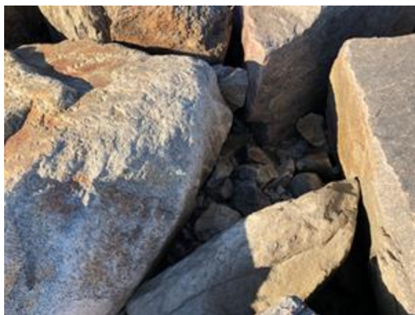
Figura 8 – Exemplo de material de filtro colocado (e exposto) imediatamente sob o manto de proteção.
