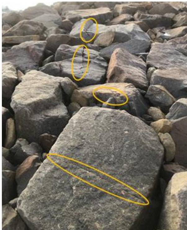
Figura 33 – Exemplo de rachas observadas no material do manto de proteção no esporão sul de Paramos.
