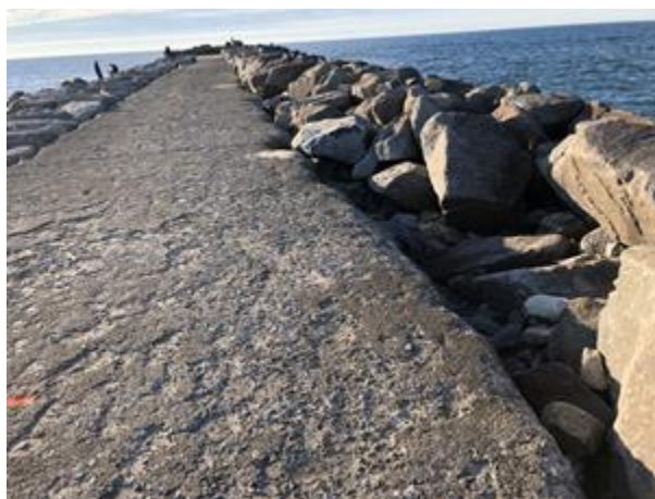
Figura 11 – Crista de talude com sinais de danos devido a galgamento.
