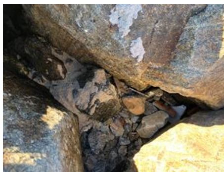
Figura 10 – Exemplo de talude com os interstícios preenchidos com materiais variados.
